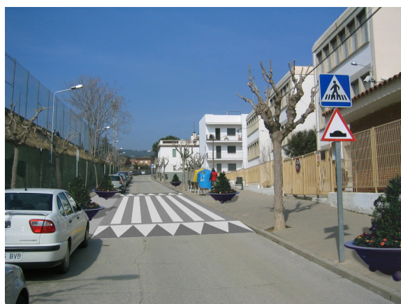
Atri i pas de vianants elevat, amb elements urbans (com per exemple jardineres) que ajuden a la reducció de velocitat.
