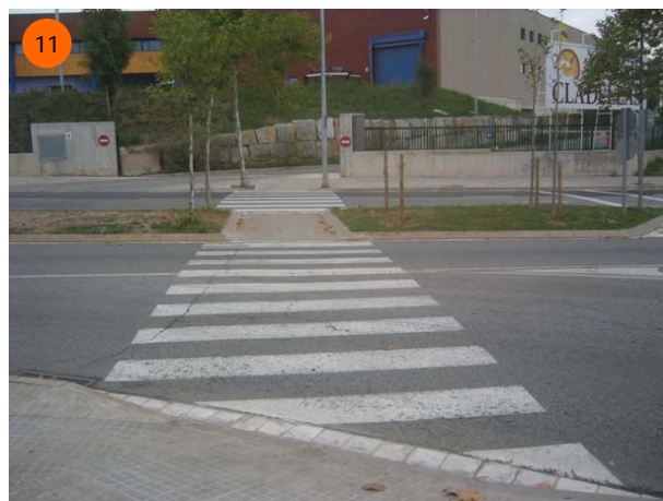
Pas de vianants sobre Ronda de Tolosa cap al camí de vianants junt a la carretera (costat P.I. Pla de la Bruguera)
