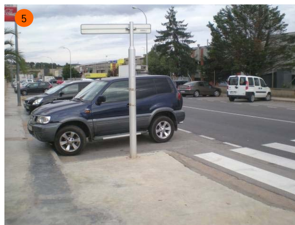
5 C. d'Osona. Si bé tots els carrils d'estacionament de la intersecció estan acotats per orelles, aquestes en ocasions estan mal dimensionades i són massa curtes. Això suposa una pèrdua d'eficàcia de la seva funció de millora de la visibilitat mútua entre vianants i conductors en els passos.
