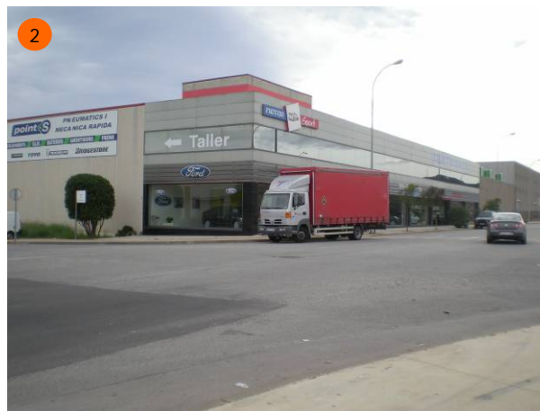
2 C. d'Osona. L'amplada dels carrils és excessiva i deixa molt espai lliure dins de la intersecció. Alguns vehicles pesants estacionen dins de la intersecció, empitjorant greument la visibilitat entre ramals.
