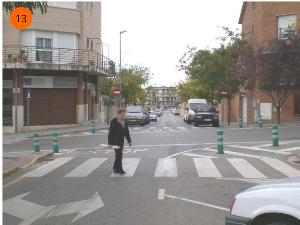
A la intersecció amb el c. Balmes s'han eliminat tots quatre els xamfrans, amb pintura i pilones. Aquest fet impedeix que els vehicles estacionin en aquests àrees. El c. Balmes té aparcament en semibateria inversa.
