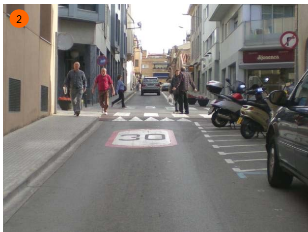
C. Hospital. Porta d'entrada a la zona 30. S'observa la disposició d'aparcament de motos abans del pas de vianants, fet que facilita la visibilitat entre vianants i conductors.
