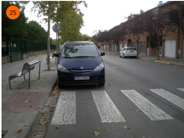
El pas situat davant de l'entrada principal del centre escolar mostra la mateixa problemàtica de visibilitat evidenciada en tot el tram per la manca d'orella.
