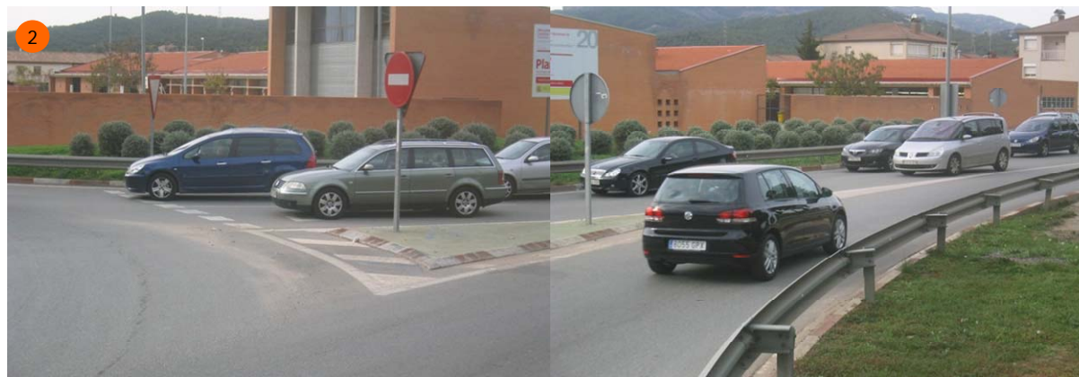
Branca rotonda de la B-124, costat Castellar. Dos carrils d'entrada (des de Castellar) i un de sortida. No hi ha passos de vianants.
