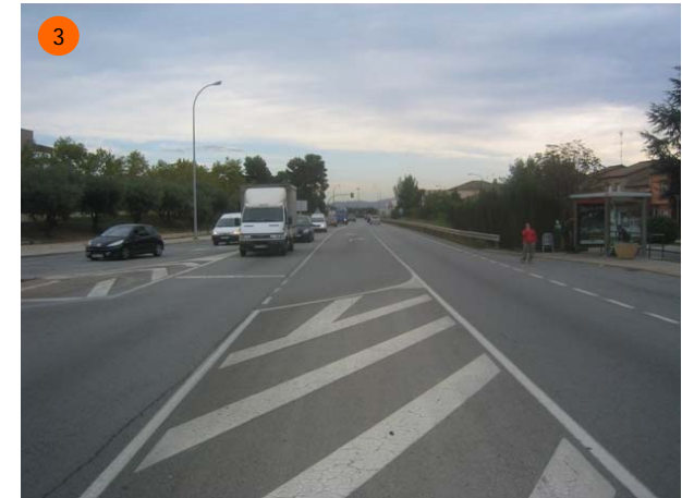
Secció amb el carril central d'incorporació des de Ronda Tolosa cap a Sabadell.
