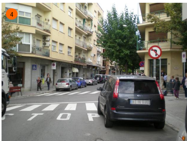
La filera d'aparcament no està acotada amb orelles en arribar als passos de vianants. Això suposa que el vehicle estacionat impedeix la visibilitat mútua entre vianants i conductors en aproximació al pas. Aquesta problemàtica es repeteix al llarg del tram.
