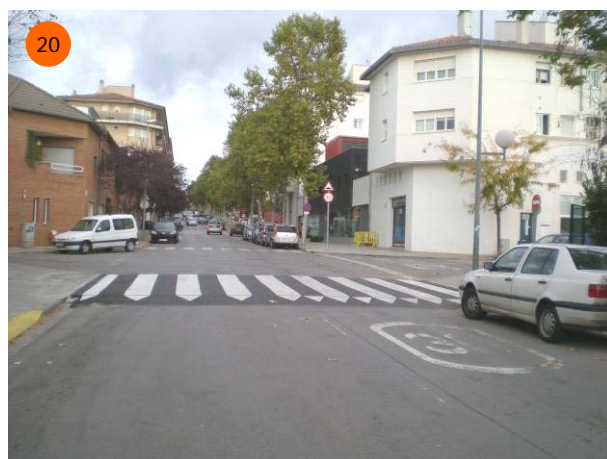
20 C. Prat de la Riba, intersecció amb c. de Josep Tarradellas . També manca d'orelles, mostra problemes de visibilitat al pas, que disminueixen l'efectivitat de la mesura d'elevat el pas de vianants.
