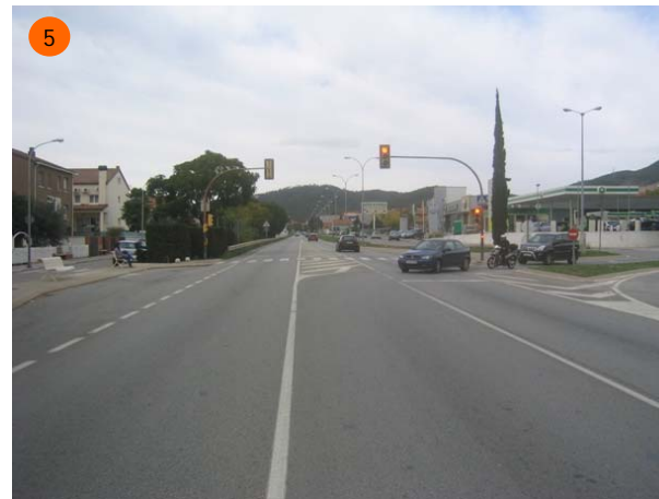
Vista de la secció amb vehicle que surt des de Ronda Tolosa cap a Sabadell.
