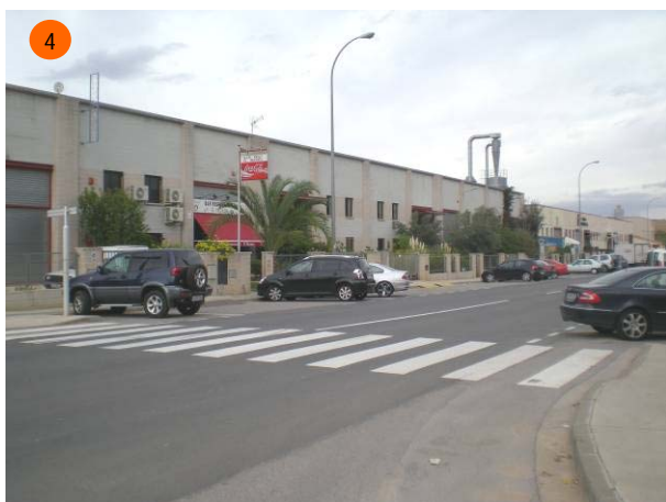
4 C. d'Osona. Com sol produir-se en zones industrials, els carrils tenen una amplada de 4m, fet que implica passos de vianants excessivament llargs. El passos de la intersecció en estudi mesuren 12 metres.
