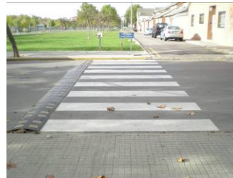
Pas de vianants amb banda rugosa prèvia. Guals no adaptats amb rampa.
