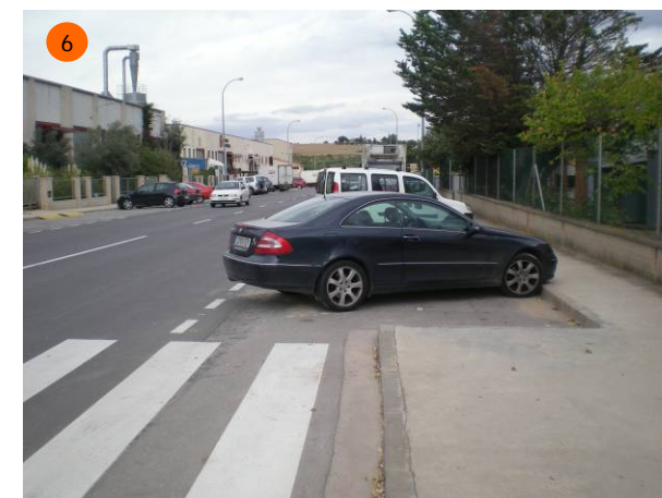
6 C. d'Osona. S'observa la mateixa problemàtica al costat oposat de la via. Semblaria que les orelles s'haguessin dimensionat per un carril d'aparcament en filera i no s'haguessin corregit en transformar-se en semi-bateria. També s'observa que els vehicles estan estacionats en semi-bateria tradicional, amb visibilitat limitada en la sortida.
