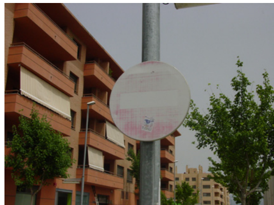
Senyal en estat deficient
