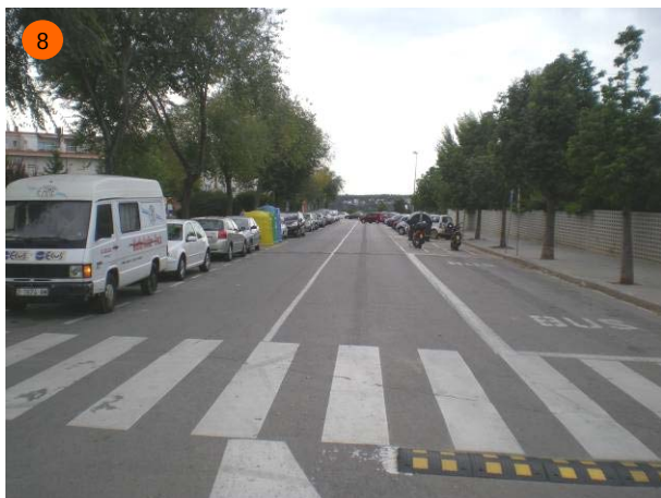
Ronda del Turuguet. Sense orelles, pas massa llarg. Bandes rugoses. Aparcament bus.
