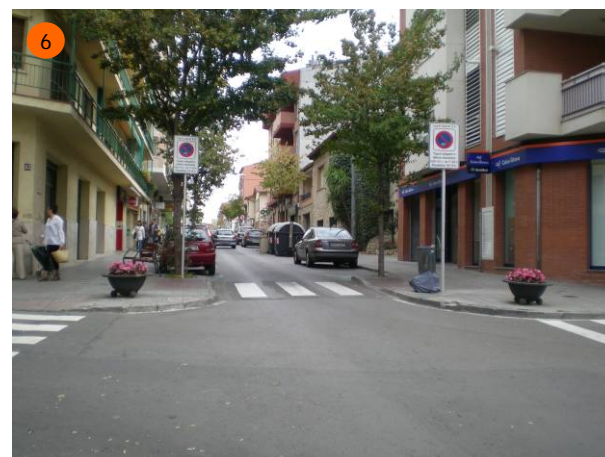
A la mateixa intersecció, a l'av. Sant Esteve ja s'han disposat orelles que acoten les fileres d'aparcament. Aquesta mesura millora la visibilitat dels passos, i disminueix la llargada dels mateixos.
