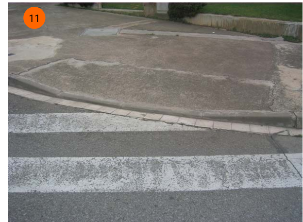
Rebaix del pas de vianants en la cantonada d'Osona amb Conca de Barberà.
