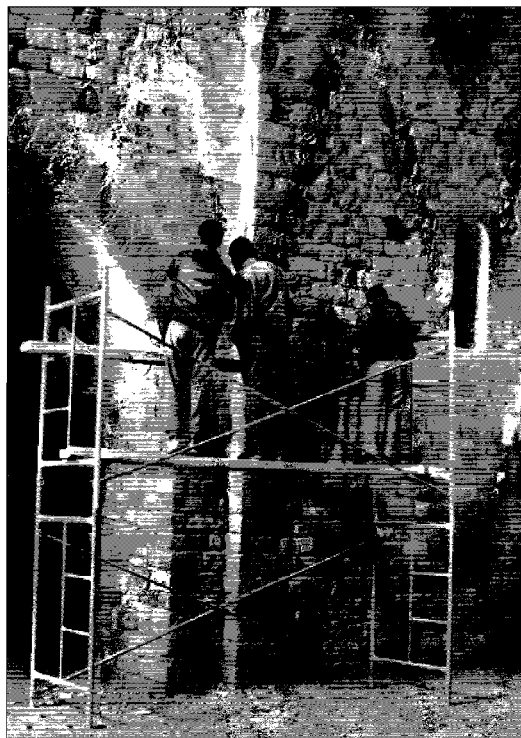
40. Tasques de restauració a l'interior de la nau de l'antiga església parroquial de Sant Esteve de Castellar, dirigides per l'arqueòleg i medievalista Albert Roig Deulofeu i l'arquitecte Josep M. Massagué.
