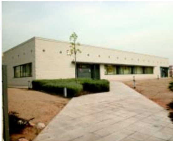
Centre de Serveis
