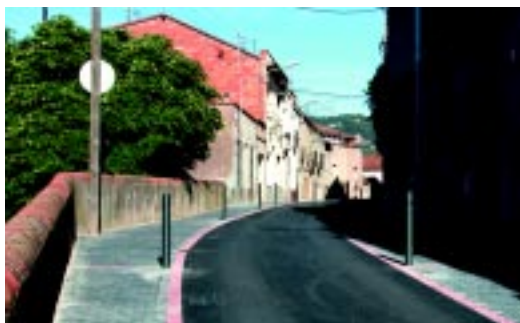
Remodelació del carrer de la Mina
