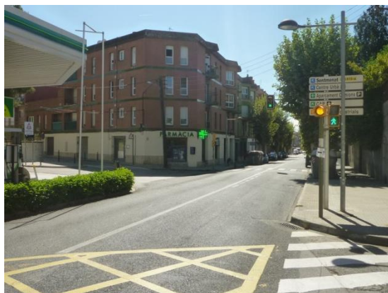
Imatge 6. Carretera de Sabadell. A l'hora punta del matí, entre les 8.00 i les 9.00 es produeixen retencions perquè hi ha vehicles que volen girar a l'esquerra, però no tenen ni un carril exclusiu per a fer-ho ni una fase semafòrica suficient.
