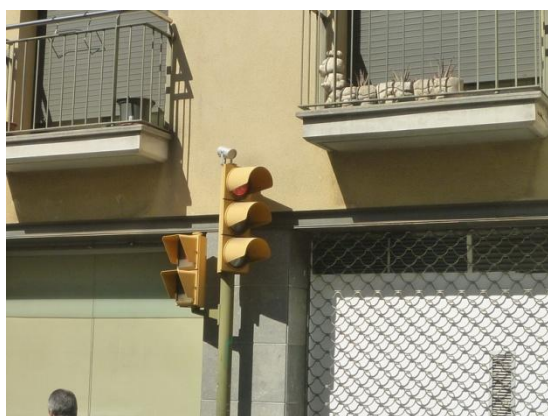
Imatge 4. Semàfor amb detector de vehicles al carrer del Molí, que activa la fase 3 del cicle semafòric
