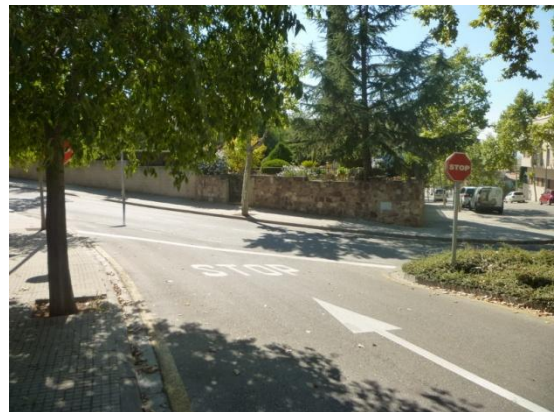
Imatge 15. El ramal de sortida des de l'av. Tramuntana a la carretera de Sentmenat té una amplada excessiva que afavoreix velocitats altes
