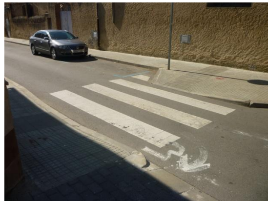
Imatge 26. Vorera amb orelles físiques en un pas de vianants al passeig de Tolrà
