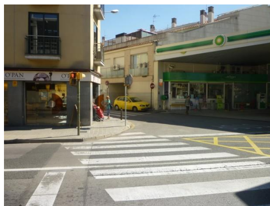
Imatge 7. Pas de vianants no adaptat a la cruïlla entre la B-124 i el carrer del Molí. A la calçada s'ha marcat una graella groga per evitar que els vehicles parats obstrueixin el pas.
