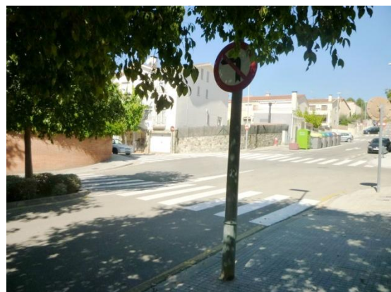
Imatge 17. Senyal de prohibit girar a l'esquerra mal ubicat, ja que el sentit de circulació de l'avinguda Tramuntana és invers.
