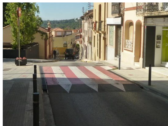
Imatge 21. Pas de vianants elevat i bicolor al carrer Major
