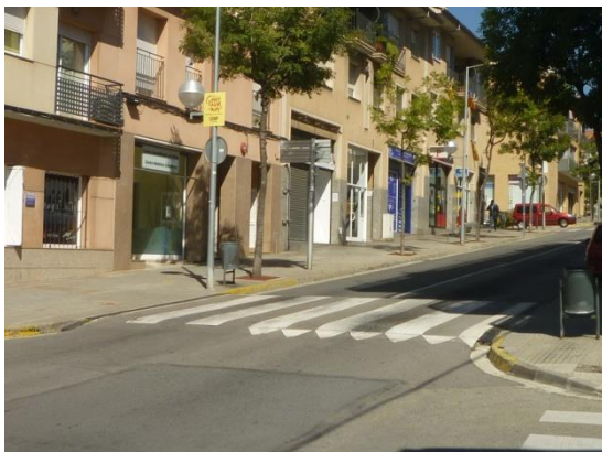
Imatge 35. Pas de vianants elevat al Passeig
