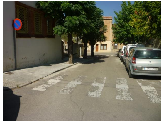
Imatge 19. Pas de vianants no accessible i amb pintura deficient al carrer Catorze d'Abril
