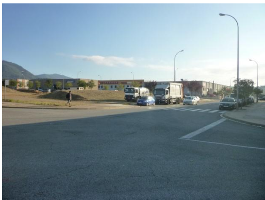
Imatge 11. C. Berguedà amb c. Osona. L'amplada dels carrils és excessiva i deixa molt espai lliure dins de la intersecció.
