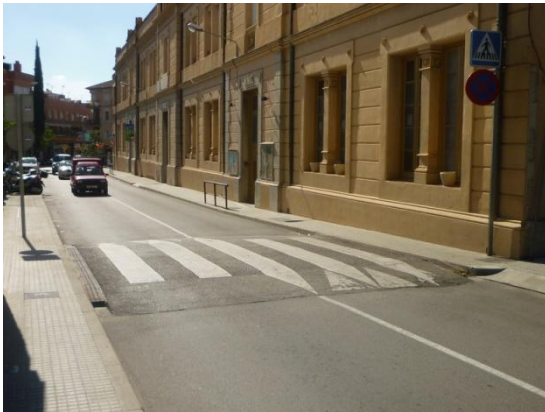
Imatge 40. Accés a un centre d'esplai, i proper a l'accés del Col·legi la Immaculada, al passeig Tolrà. Hi ha una balla metàl·lica davant la porta i un pas de vianants elevat a pocs metres de la porta
